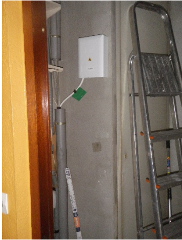
Pose des boîtiers étages => fibres optique dédiés par logements
