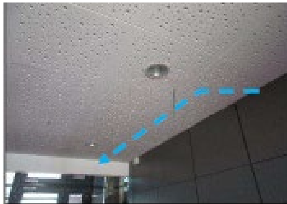
Raccordement des logements par les faux plafond
