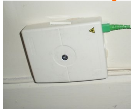
Prise optique => installation faite lors du premier raccordement client
