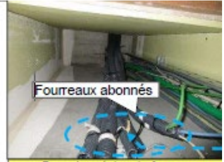
Dans les gaines techniques => passage fourreaux abonnés
