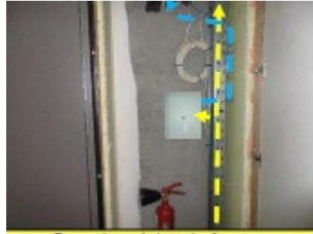
Dans les gaines techniques => passage fourreaux abonnés
