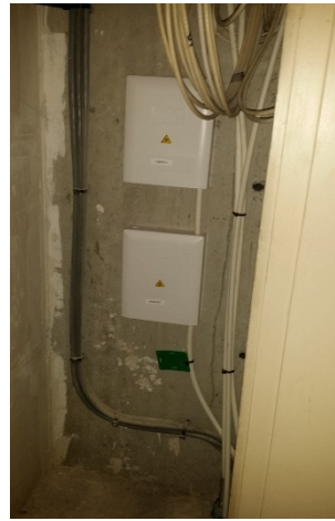
Pose des boîtiers étages => fibres optique dédiés par logements
